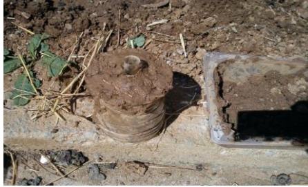
Σχήμα 5 : Κατασκευή πλίθινου κυλινδρικού στοιχείου
