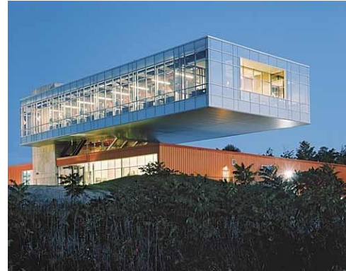
Σχήμα 3: Κάμψη πακτωμένης ράβδου λόγω φορτίων. Εφαρμογή προβόλου (δεξιά)
